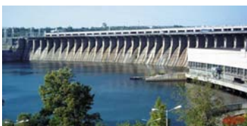
Дніпрогес Дніпровська гідроелектростанція
